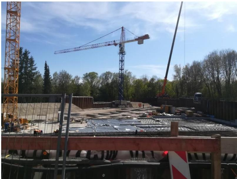
19.5.2020 Beginn Betonierung der Bodenplatte
