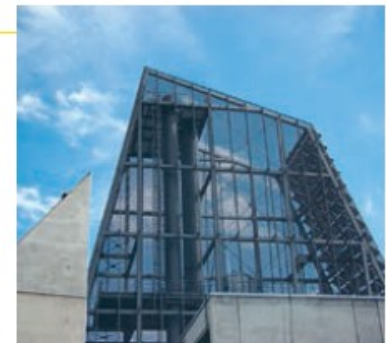
Die Geothermianlage an der Bodenseeallee
